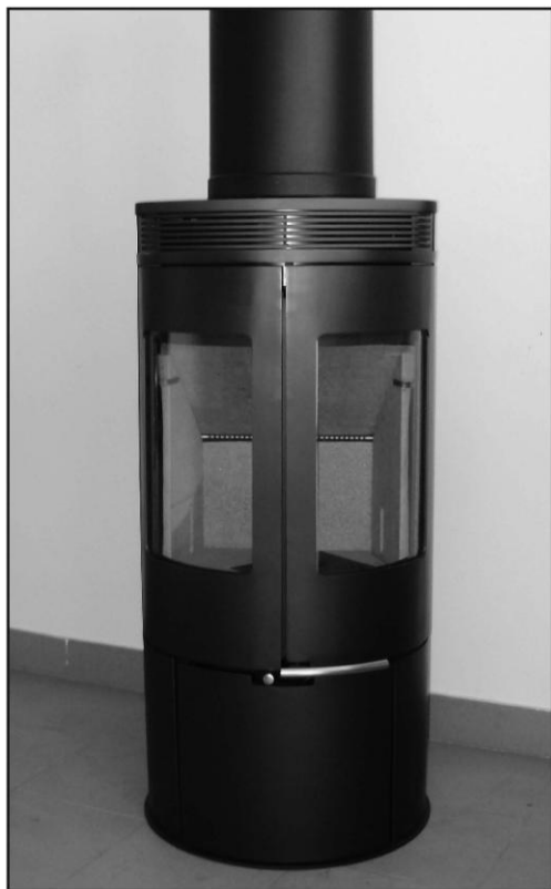
Svea Flame Step by Step i svart lack, toppanslut- ten och färdiginstallerad för besiktning av skor- stensfejarmästaren.
